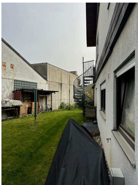
Abbildung 1: Blick auf Grenzbebauung
